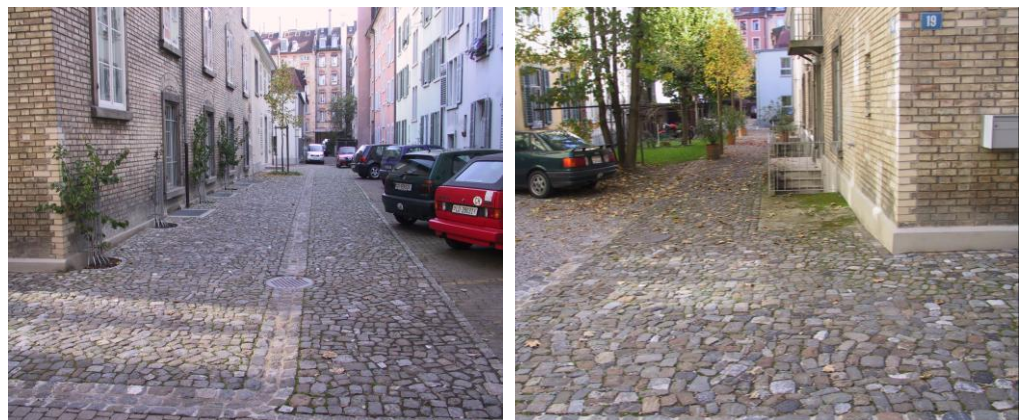
■ Pflastersteine ■ Splittbettung ■ Kiesfundationsschicht ■ Fugenfüllstoff
